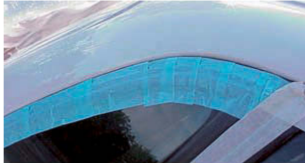
Foto 32 - Aknatihendite katteteip paigaldatuna
