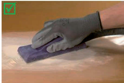
Foto 80 - Õige lihvimisklotsi asend pinna suhtes
