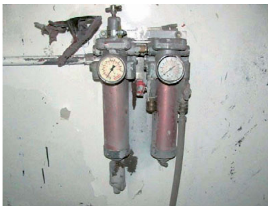
Foto 60 – Mitterahuldavas olukorras suruõhufiltrid
