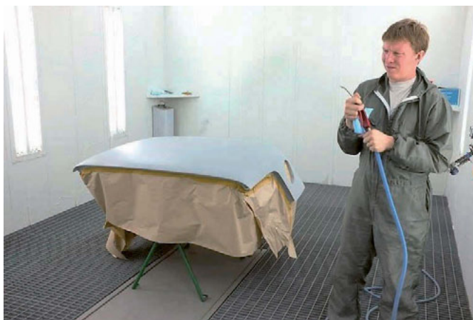
Foto 122 – Viimane puhastus õhuga ja automaaler on värvimiseks valmis
