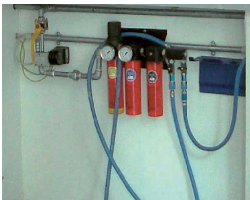
Foto 59 – Heas korras suruõhu filtrite süsteem
