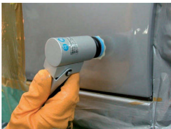
Foto 78 – Defektide eemaldus miniatuurse lihvjaga
