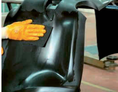
Foto 35 – Kasutage puhastamisel pesuainega immutatud „karukeelt“
